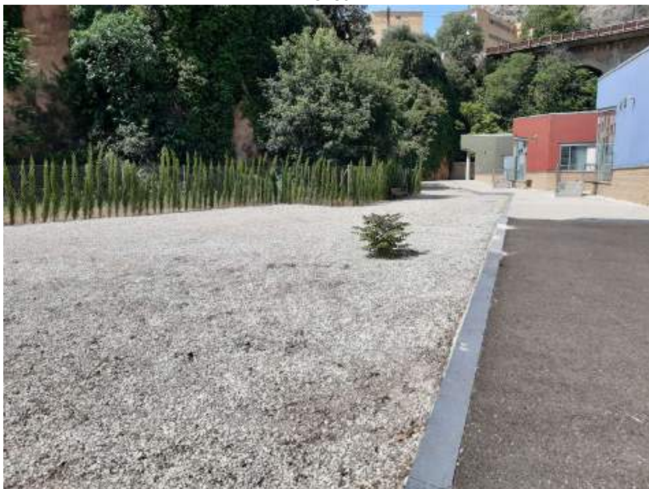
Zona de grava suelta donde se solicita colocar césped artificial
