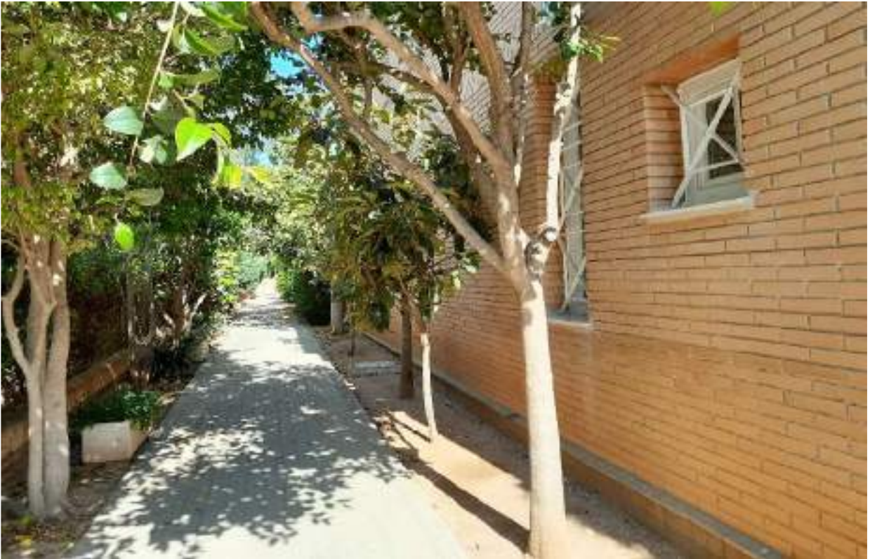
Pasillo lateral con jardineras con necesidad de podas de formaci n, desbroces y plantaci n
