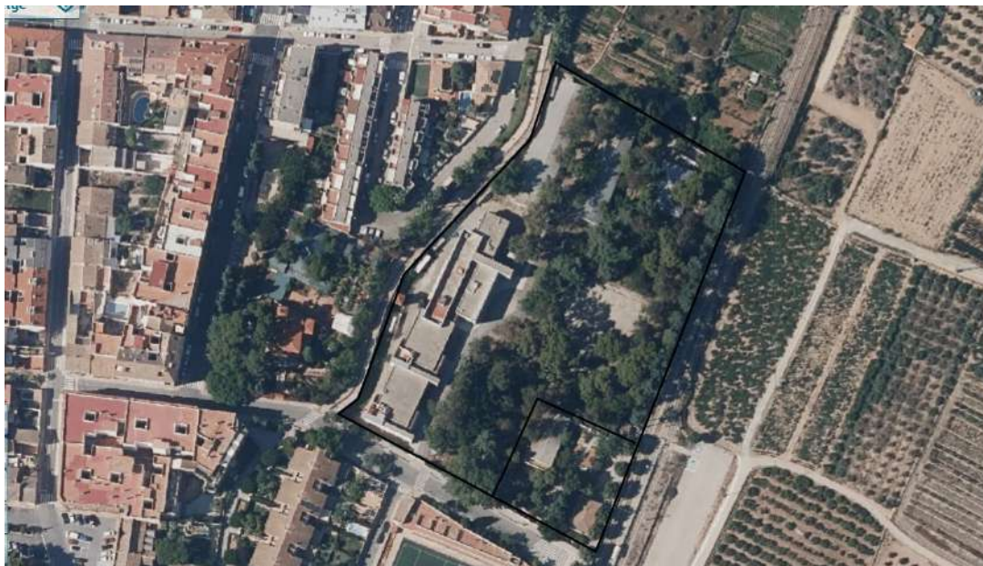
Foto nº7: vista de la residencia y vivienda tutelada de Rocafort. Fuente: www.visor.qva.es
