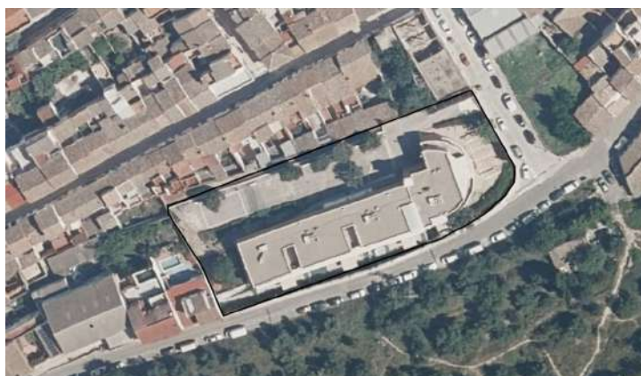
Foto nº4: vista de la residencia Caixa Ontinyent. Fuente: www.visor.gva.es
